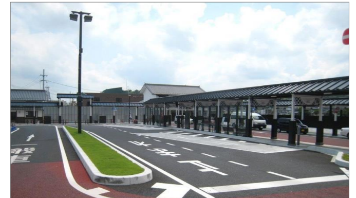
▲津山駅北口広場整備工事(津山市)
