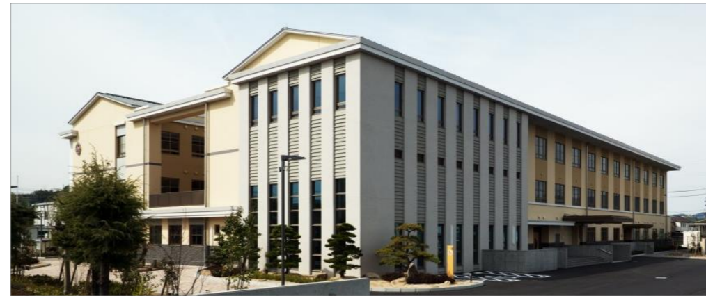
▲玉島小学校校舎建築工事(倉敷市)
