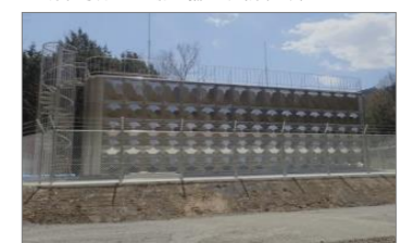
▲西河内第2配水池築造工事(真庭市)
