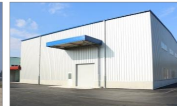
▲三和パッキング工業(株)倉庫新築工事(美作市)
