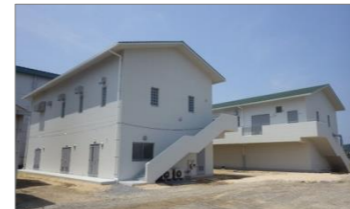
▲瀬戸内市長船水源地更新工事(瀬戸内市)
