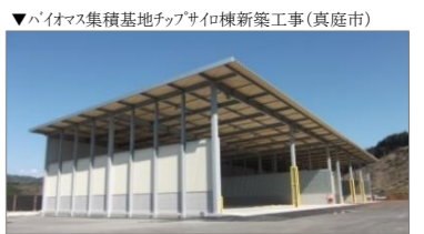
▼バイオマス集積基地チップサイロ棟新築工事(真庭市)
