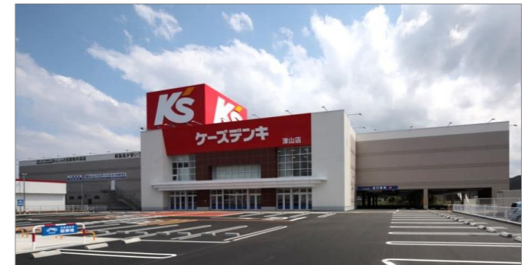
▲(仮称)ケースデンキ津山店新築工事(津山市)
