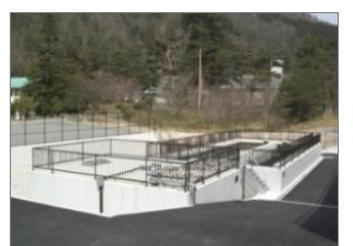
▲簡易水道井坂浄水場新設工事(鏡野町)
