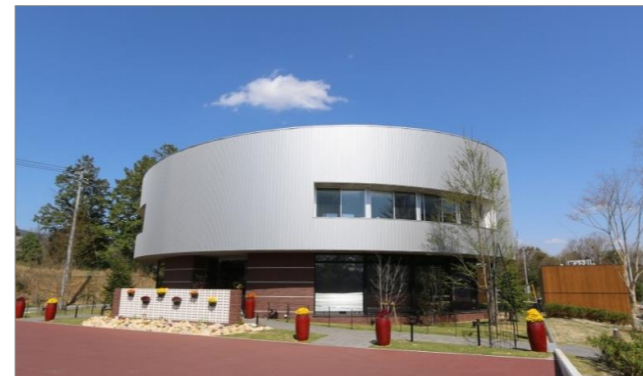
▲メディカルプラザ新築工事(津山市)
