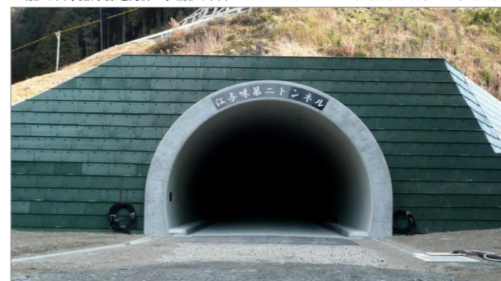
▲公共道路工事<江与味第二トンネル>(美咲町)
