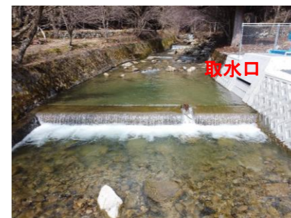
取水堰 吉野川の水を堰き止めて取水しています。
