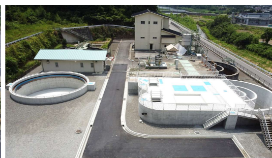
▲真庭市落合浄化センター建設工事 (真庭市)
