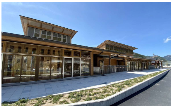
▲西粟倉村つどい・くらしの拠点施設建設工事 (西粟倉村)
