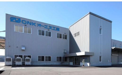
▲オーエヌ工業株式会社倉庫棟他建設工事 (津山市)
