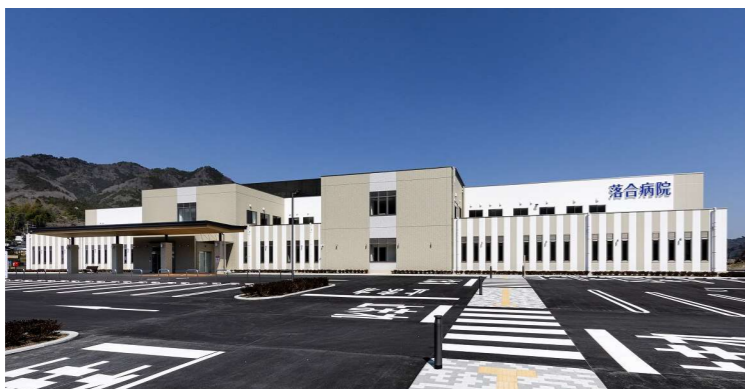
▲医療法人社団井口会 落合病院 新築工事 (真庭市)
