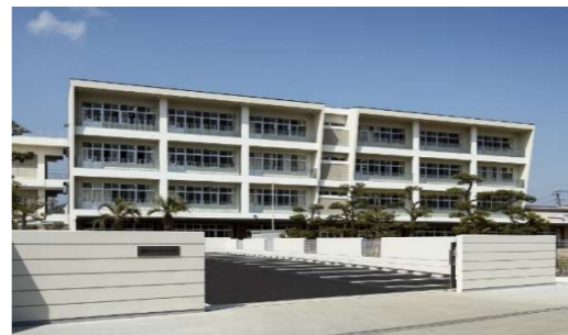
▲西阿知小学校・幼稚園複合施設増築他工事 (倉敷市)
