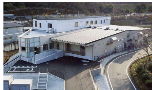
▲落合学校給食共同調理場建築工事 (真庭市)
