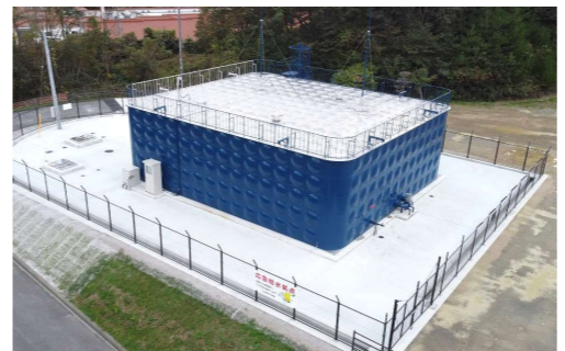
▲久世配水池築造工事 (真庭市)
