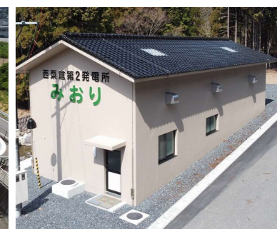
▲西粟倉第2発電所建設工事 (西粟倉村)
