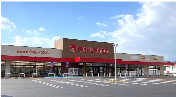
▲マルナカ灘崎店新築工事 (岡山市)
