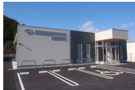
▲浅野産業株式会社真庭事業所新築工事 (真庭市)
