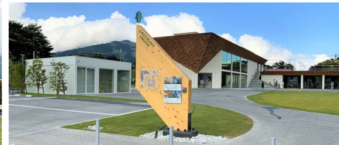
▲CLTサイクリングセンター・外構整備工事 (真庭市)
