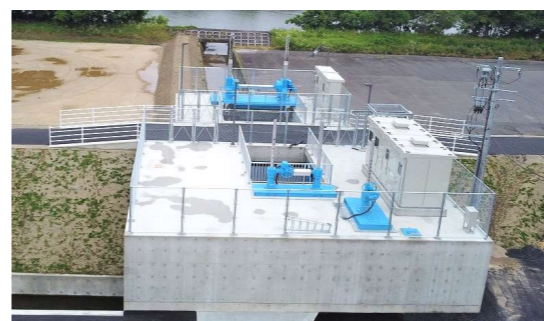
▲昭和町第2ポンプゲート躯体工事 (津山市)
