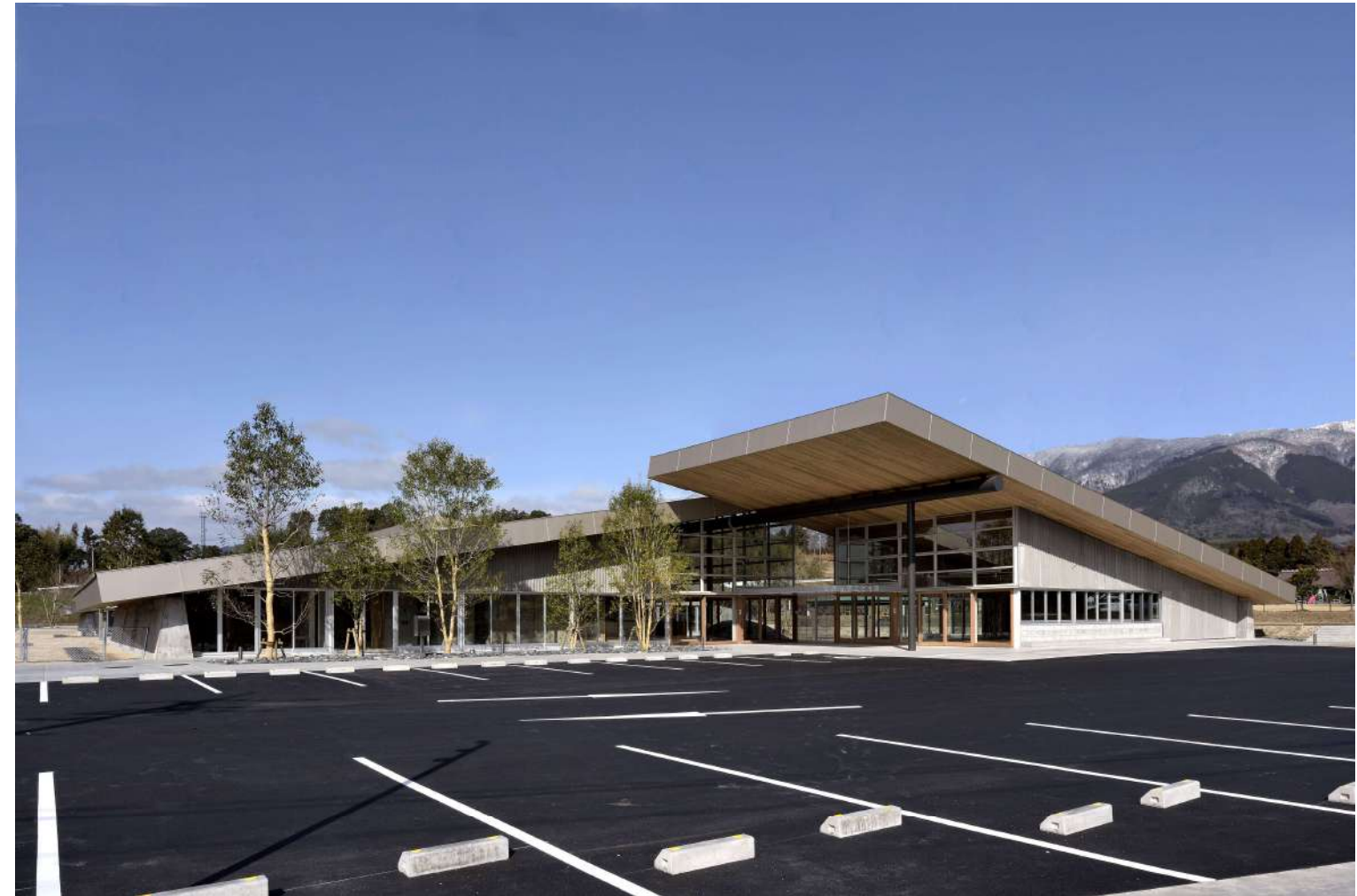
奈義町立こども園建設工事
